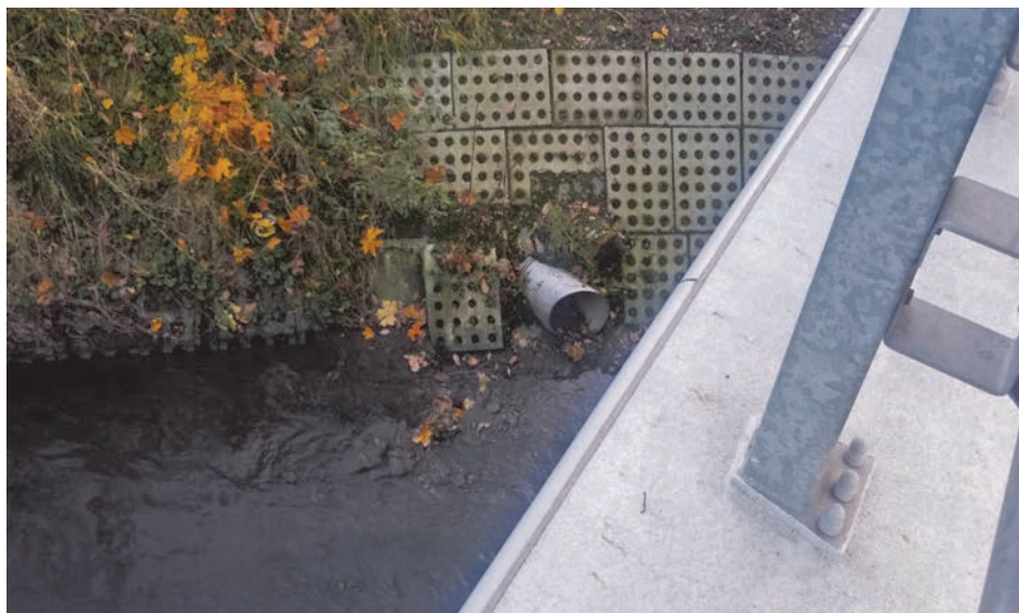
Fot. 33. Widok z mostu przy ul. Hagera – ażurowe, betonowe umocnienia brzegu, wylot kanalizacji deszczowej (fot. Maciej Kostecki)
