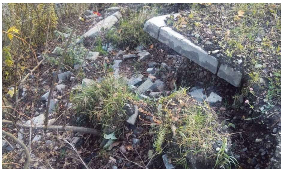
Fot. 38. Rzeka Bytomka – sąsiedztwo mostu przy ul. Hagera –oberwane umocnienia betonowe prawego brzegu rzeki (fot. Maciej Kostecki)
