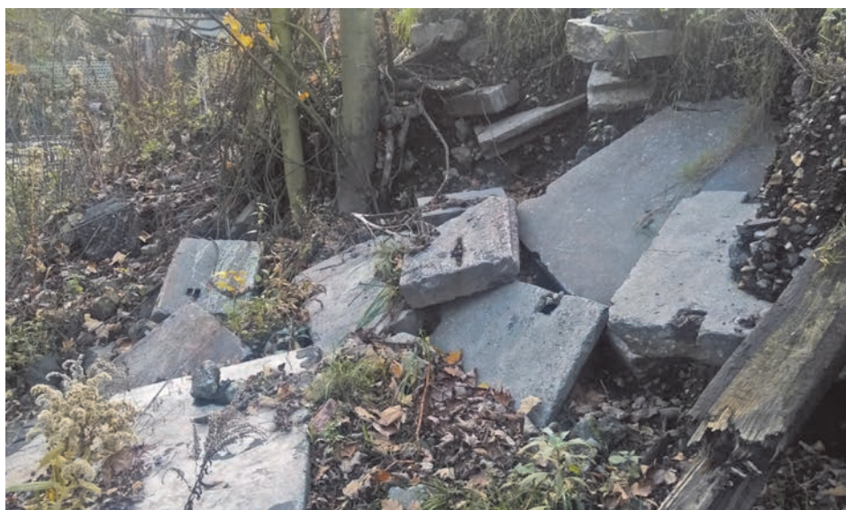
Fot. 36. Rzeka Bytomka – sąsiedztwo mostu przy ul. Hagera –oberwane umocnienia betonowe prawego brzegu rzeki (fot. Maciej Kostecki)
