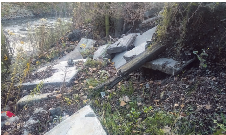
Fot. 37. Rzeka Bytomka – sąsiedztwo mostu przy ul. Hagera –oberwane umocnienia betonowe prawego brzegu rzek. (fot. Maciej Kostecki)
