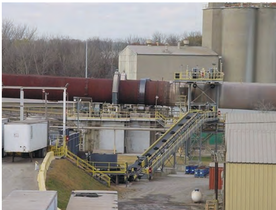
Rys. 25. Utylizacja zużytych opon w piecu do wypalania klinkieru (zdjęcie zagranicznej cementowni)
